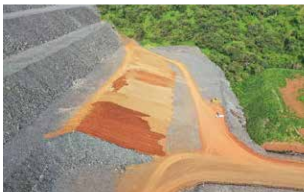
Décharge de stériles de Mako, août 2021
