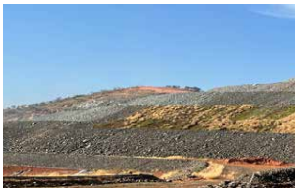
Décharge de stériles de Mako, août 2023
